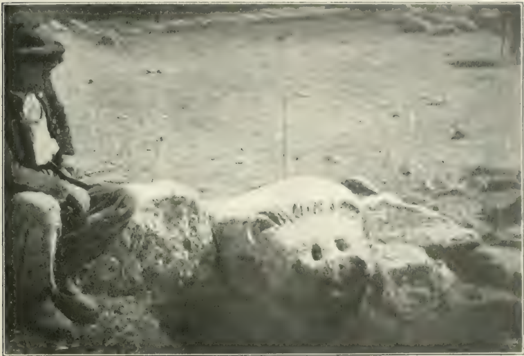
Abb. 40. Löwenkopf als Wasserspeier im Wasserbehälter ez-ziknani .
