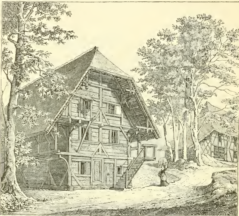
Ständerbau mit Blockwand. (Stanton Aargau.)
