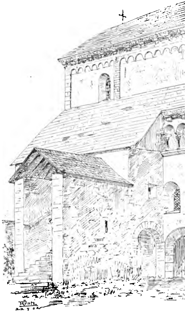
Abb. 7. Ansicht des südl. Treppenaufganges vor der Herstellung.
