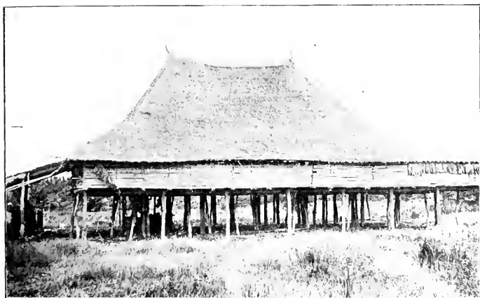
Grosses Pfahlhaus mit Türenvordach links.
