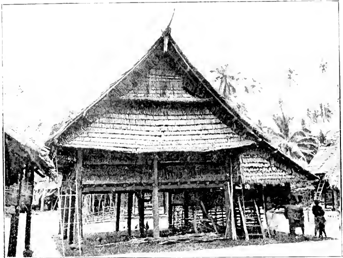
Pfahlhaus, dessen schräg gestellte Pfeiler auf Steinbasen gestellt sind.
