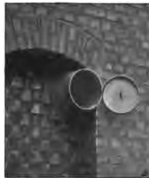
Kühlhausentlüftungsrohr nach Matschke.
