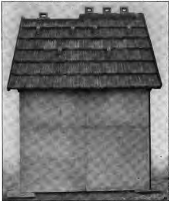
Fig. 7. Dachmodell mit Ventilationskappen.
