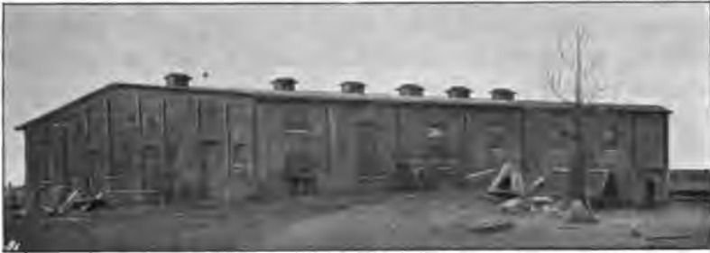
Fig. 2. Massives Stallgebäude ohne Zwischendecke mit Pappdach und Luftschächten.
