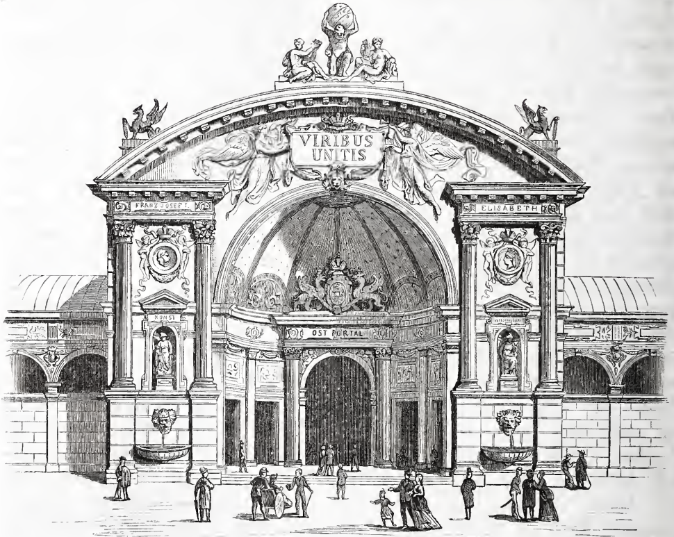
Ostportal der Industriehalle.
