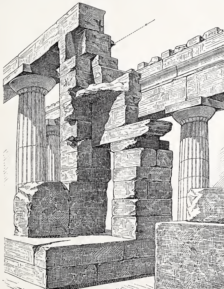
Fig. 3. Die Cella des Poseidontempels, von der südlichen Halle des Säulenganges gesehen. (NB.: Der Pfeil weist auf die Antenhohlkehle, deren nordöstliche Kante von hier aus in scharfem Profil gesehen wird.)
