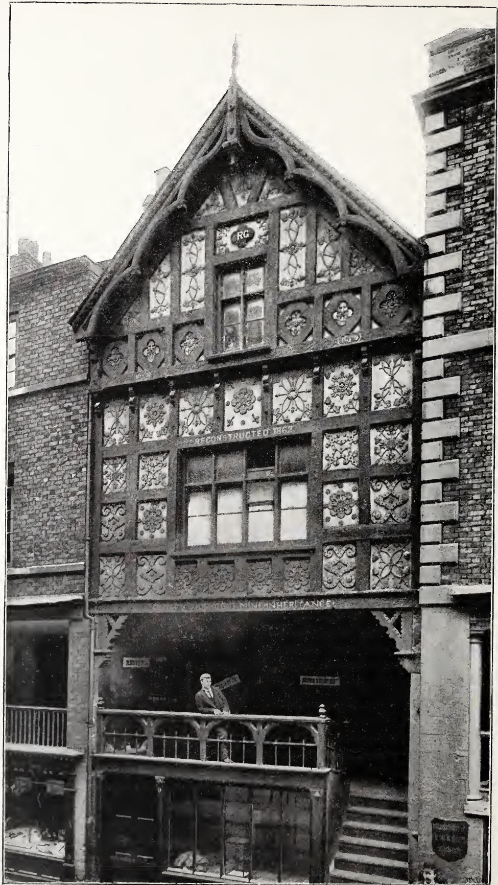
Abb. 7. Holzhaus in Chester, erbaut 1652.
