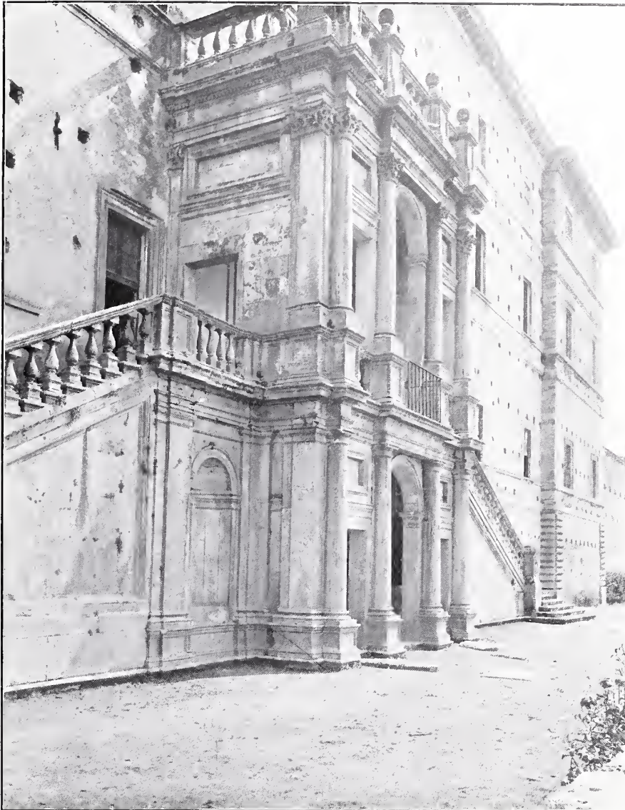
ABB. 17. VILLA D'ESTE. ÄUSSERE TREPPE
