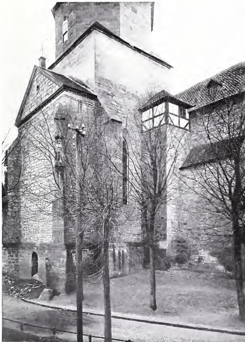
ABB. 8. MORITZBERGER KIRCHE, NORDOSTECKE
