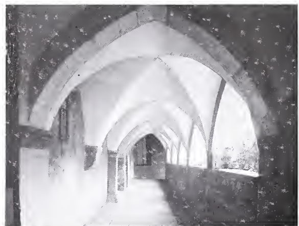
ABB. 10. KREUZGANG DER MORITZBERGER KIRCHE ÖSTLICHER ARM
