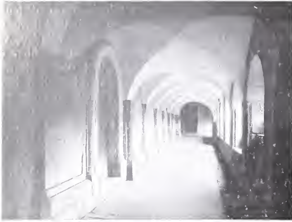
ABB. 9. KREUZGANG DER MORITZBERGER KIRCHE NÖRDLICHER ARM
