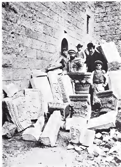
Abb. 19. Gioia del Colle. Teile der Hoftreppe u. a. vor der Wiederherstellung
