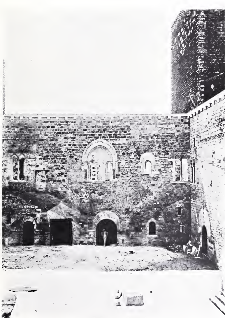
Abb. 7. Gioia del Colle. Die Südwand, Hofseite
