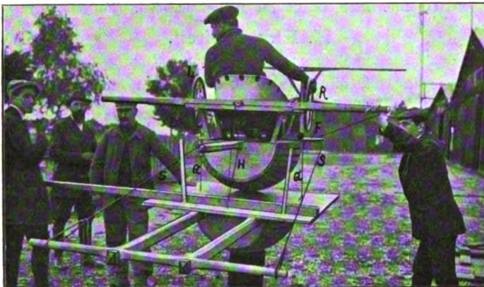
Fig. 16. Lehrapparat von »Antoinette«, // Halbkugel mit dem Führersitz, R Handrad für die Höhensteuerung, L Handrad für die Quersteuerung mittels der Seile, F Fußhebel für die Seitensteuerung mittels der Seile S.
