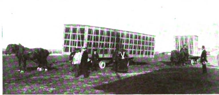
Transport von in Lattengestellen verpackten Flugapparaten.
