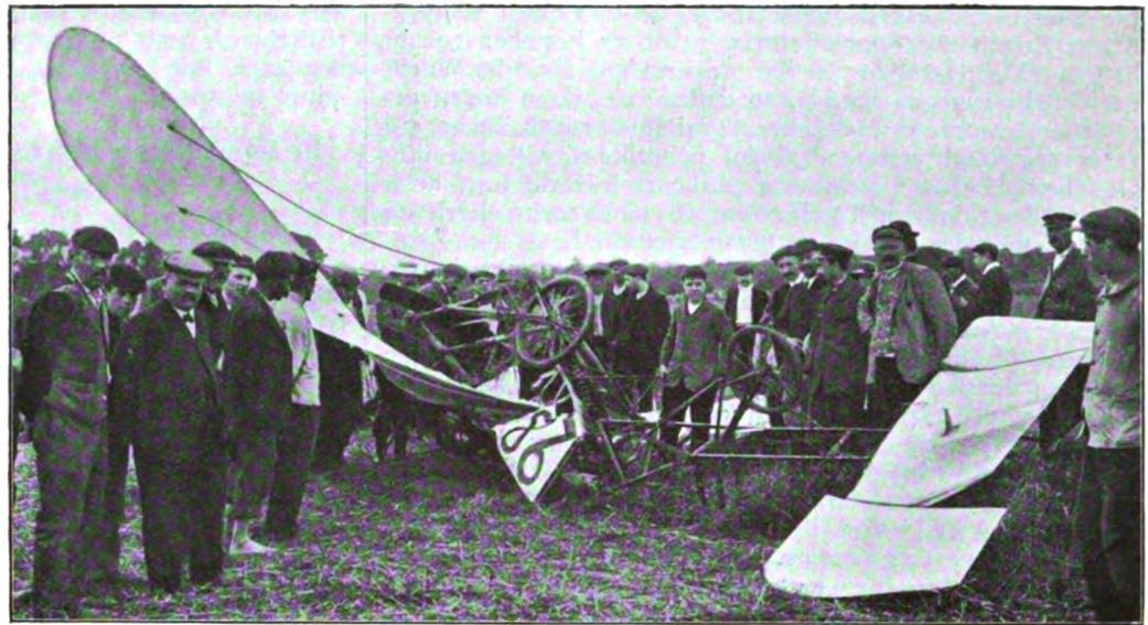
Fig. 3. Der zerschmetterte Blériot-Eindecker von Busson. Abgestürzt 70 km nach dem Start infolge Motordefekts.
