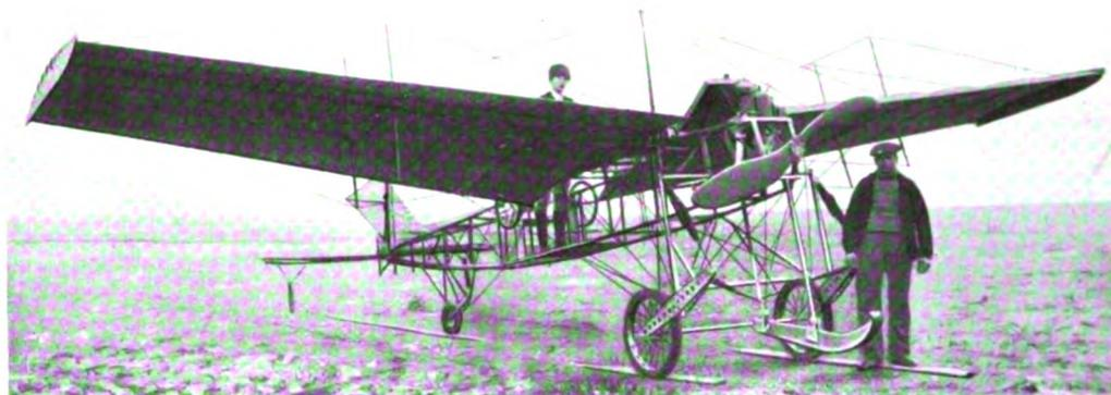
Eindecker von Barrillon, Zweizylindermotor, Motor System Bertheaud, 25 PS.
