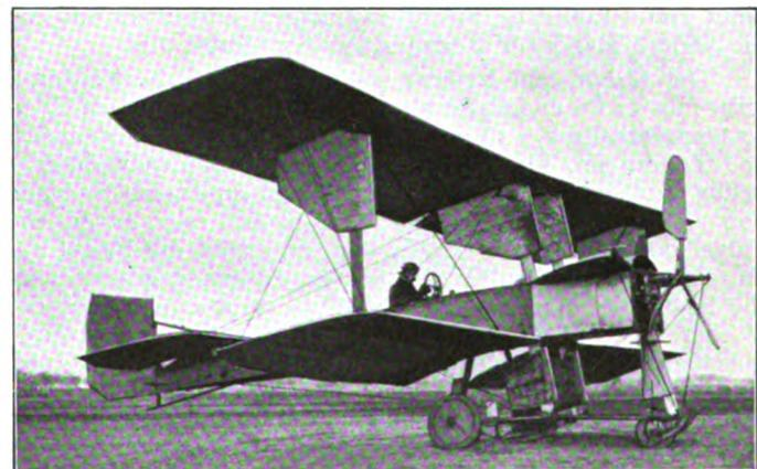
Fig. 17. Zweidecker von Breguet, Seitenansicht (vom Konstrukteur doppelter Eindecker genannt).
