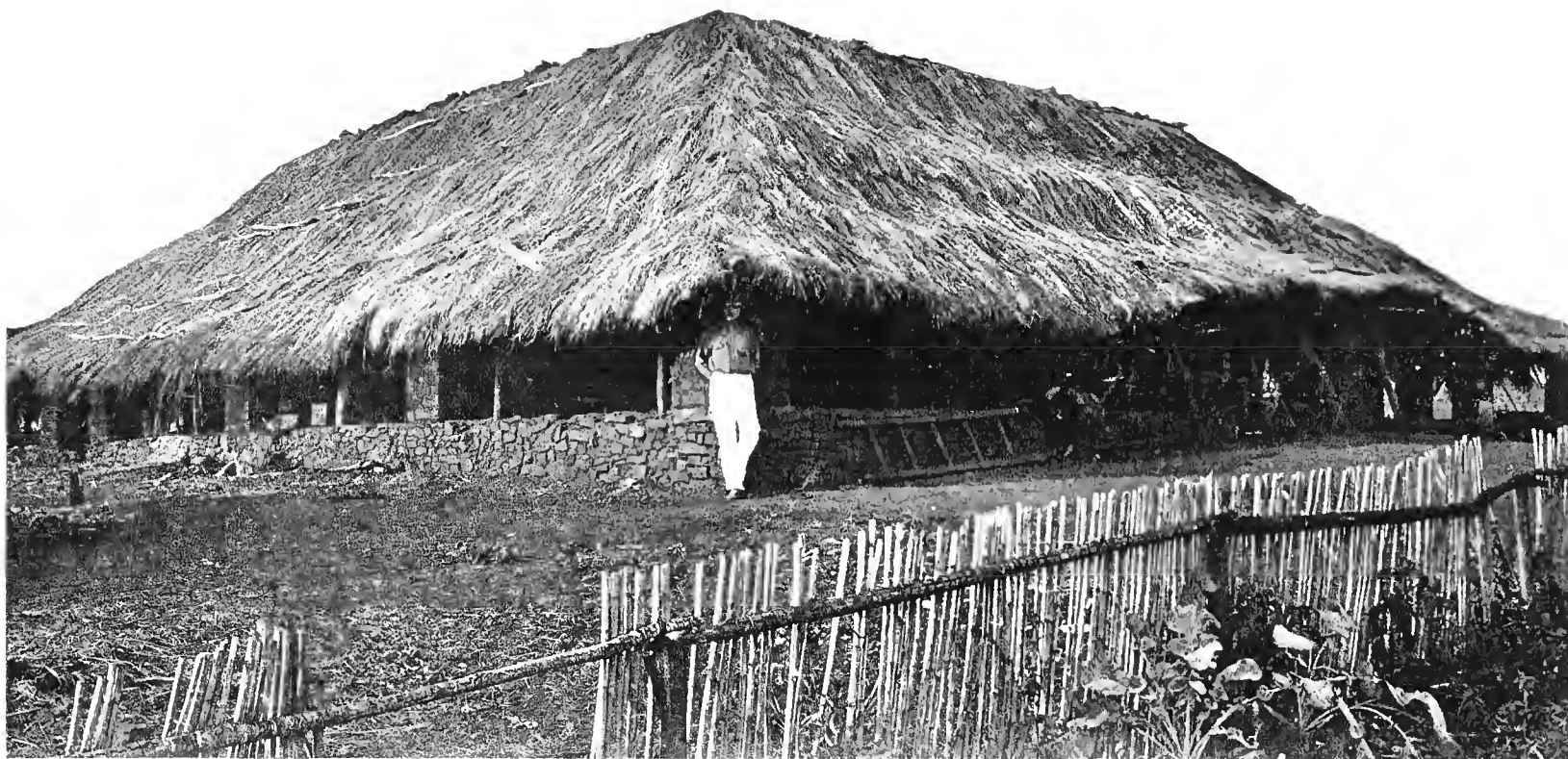
32. DIE STATION KOROGWE DER D.-O.-A. GESELLSCHAFT, SEITENANSICHT DES HAUPTGEBÄUDES.
