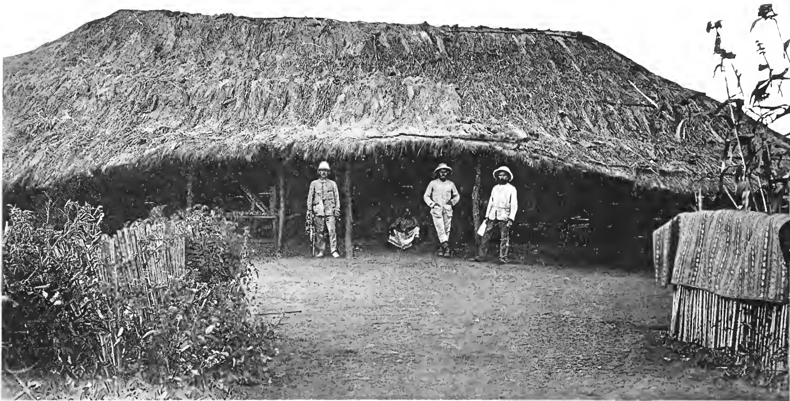
31. DIE STATION KOROGWE DER D.-O.-A. GESELLSCHAFT, VORDERANSICHT DES HAUPTGEBÄUDES.
